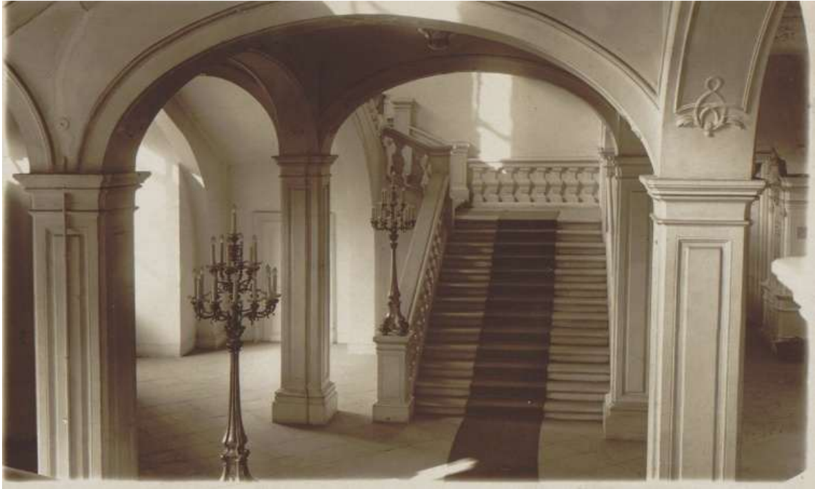
Abb. 74 f: Deutschhaus, Treppenhaus (Aufnahme 1919)
